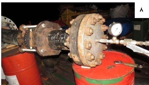
شکل ۱۱: مراحل مختلف نصب End Fitting بر روی لوله ارتجاعي
