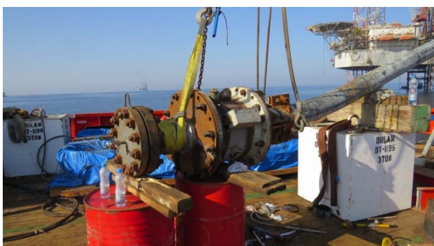
شکل ۱۲: Seal کردن محل های اتصال End Fitting به لوله
