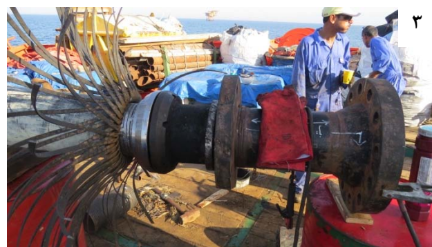
شکل ۱۱: مراحل مختلف نصب End Fitting بر روی لوله ارتجاعی (ادامه دارد)
