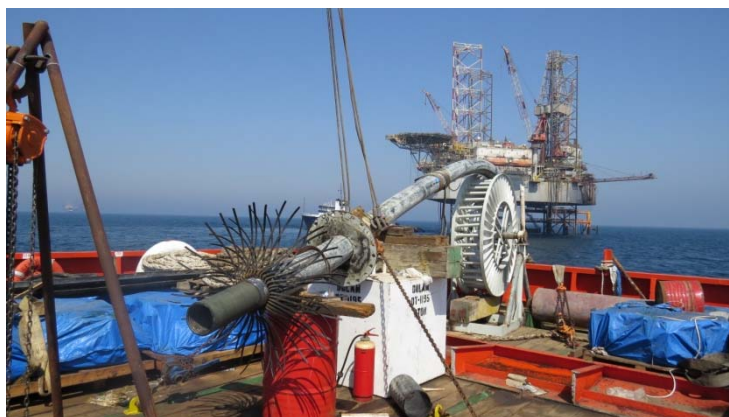
شکل ۱۰: خط لوله ارتجاعی پس از بالا کشیدن از بستر دریا و ثابت شدن روی عرشه کشتی غواصی به منظور انجام تعمیرات
