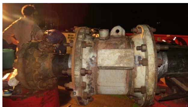
شکل ۱۲: Seal کردن محل های اتصال End Fitting به لوله
